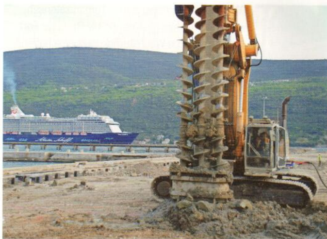
Mit voller Kraft hinab in die Erde: die Profis von Bauer Spezialtiefbau bei Arbeiten in Montenegro.
